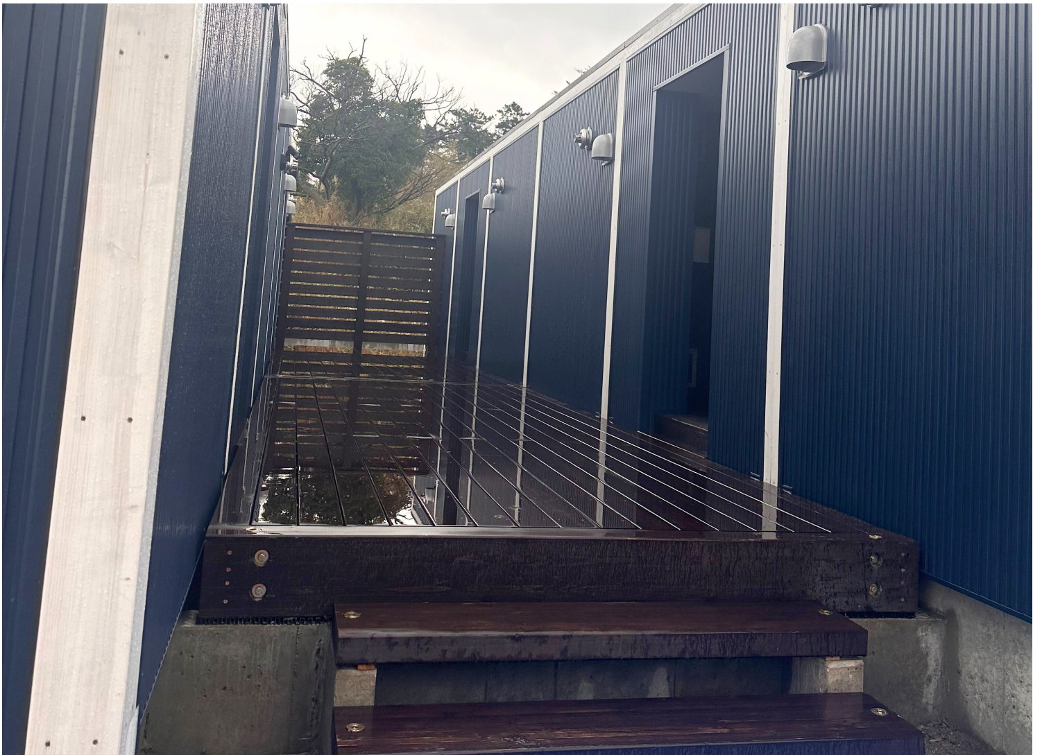
移住者用の住居(建設中)
